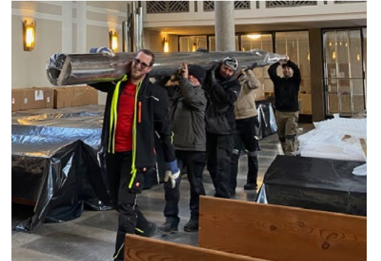
Die großen 16'-Pfeifen mit einer Länge von über 5 m und einem Gewicht von ca. 50 kg werden einzeln in die Kirche getragen.
