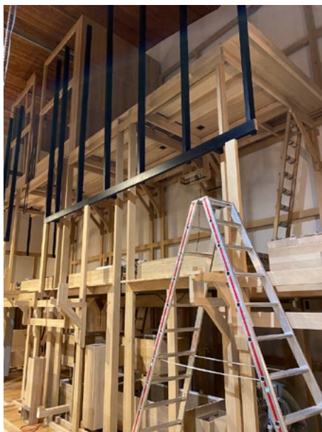
Das Gehäuse der neuen Orgel ist aus massiver französischer Spessart-Eiche geschreinert.
